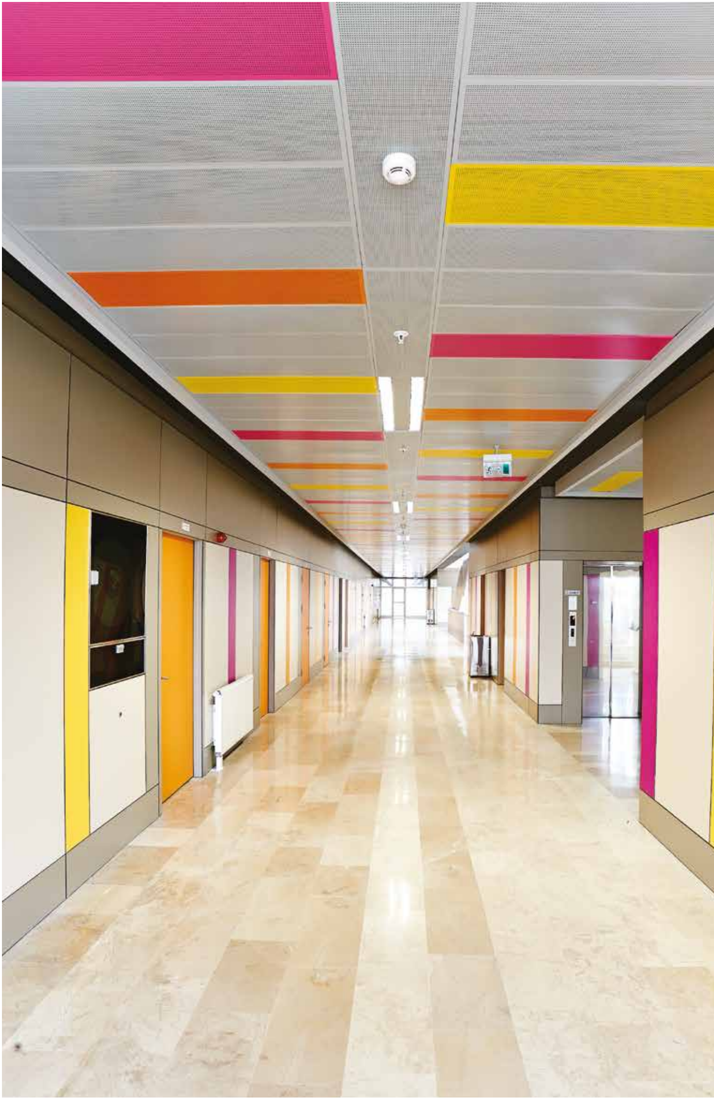
Faux plafond métalique
