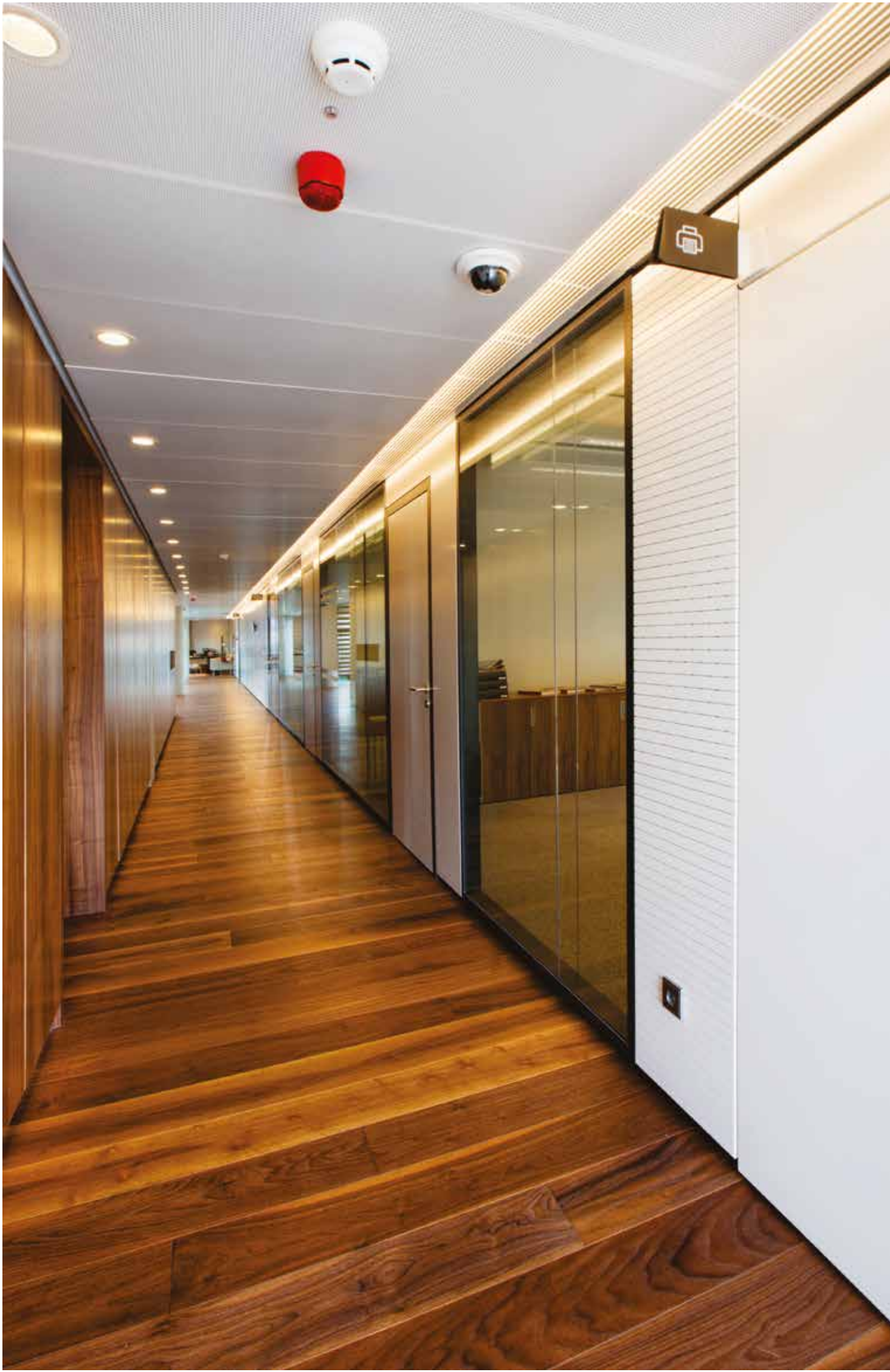
Faux plafond métalique
