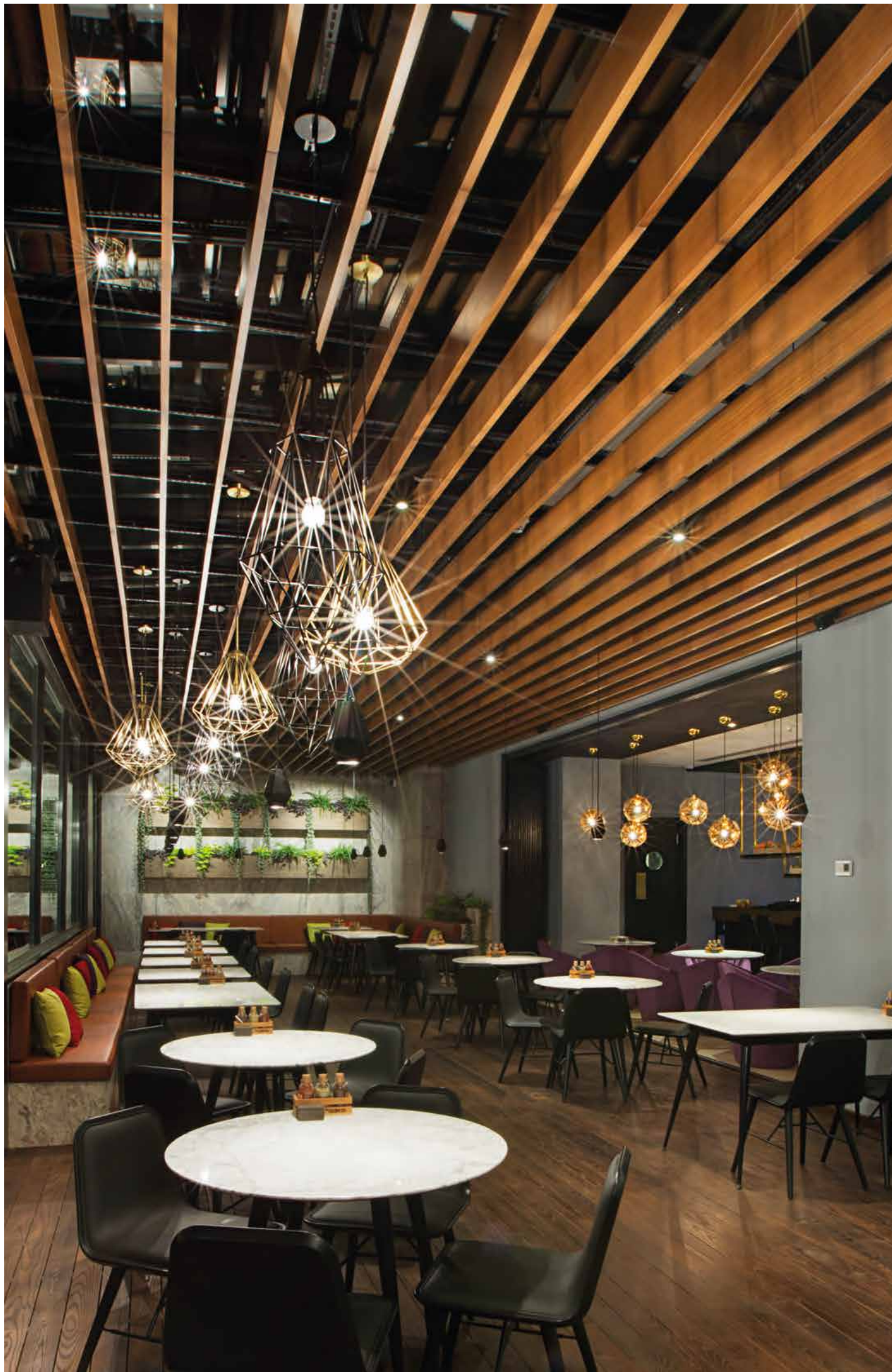
Faux plafond métalique
